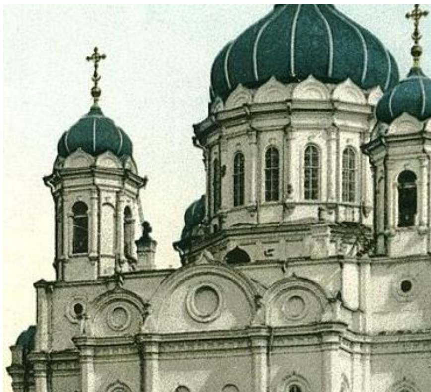
г. Томск. Троицкий собор. Строился по типовому проекту К. А. Тона с 1844 г. Килевидное завершение прясел западного фасада. Дореволюционная открытка. Фрагмент.
